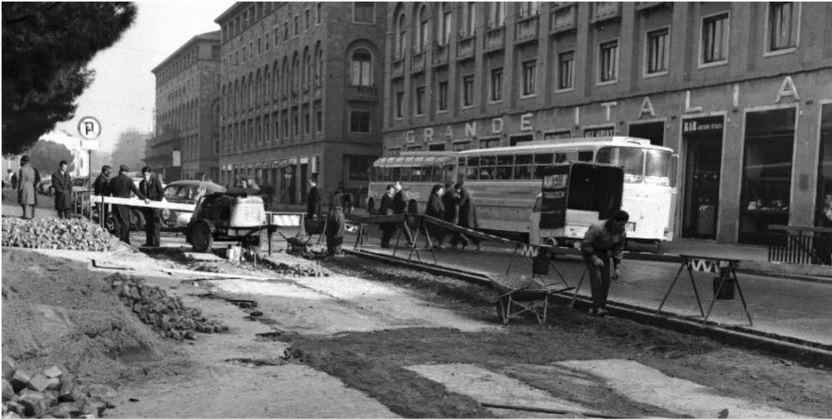
1965 - Lavori di realizzazione di una nuova pensilina alla stazione di Santa Maria Novella (Archivio storico New Press Photo)
